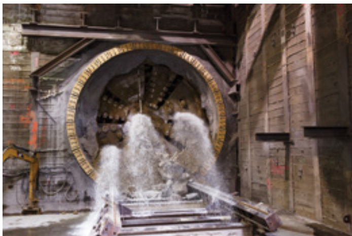
Máquina perforadora de túneles en la estación Leimert Park
